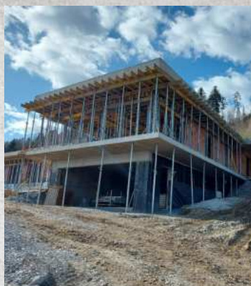
Stropní bednění SCAFLEX
