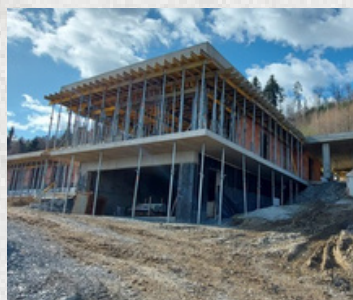
Stropní bednění SCAFLEX
